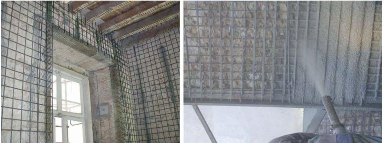
Slika 1 Primjer postavljene armature prije torkretiranja zida
